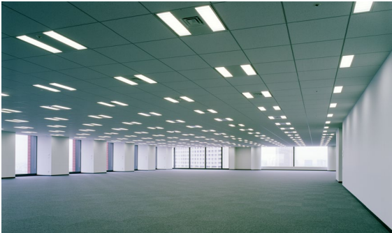
レイアウト変更に対応する「グリッドシステム天井」
